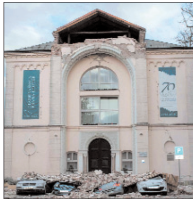
A földrengés megrongálta a zsinagógát Sziszekben
